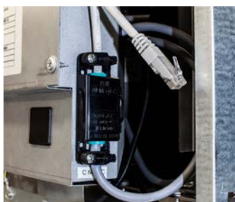
KESKUSHÄLYTYSLIITÄNTÄ RJ45 KAAPELI KYTKETTYNÄ
