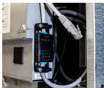
KESKUSHÄLYTYSLIITÄNTÄ RJ45 KAAPELI KYTKETTYNÄ
