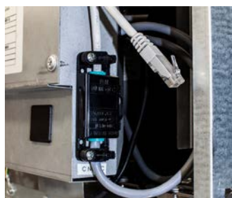
KESKUSHÄLYTYSLIITÄNTÄ RJ45 KAAPELI KYTKETTYNÄ
