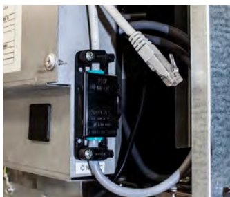
KESKUSHÄLYTYSLIITÄNTÄ RJ45 KAAPELI KYTKETTYNÄ
