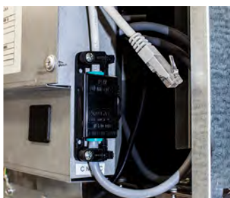
KESKUSHÄLYTYSLIITÄNTÄ RJ45 KAAPELI KYTKETTÄNÄ
