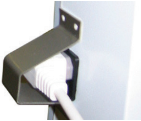
Kuva 12. Karmivastuksen kaapeli ja suojus
