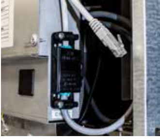
KESKUSHÄLYTYSLIITÄNTÄ RJ45 KAAPELI KYTKETTYNÄ
